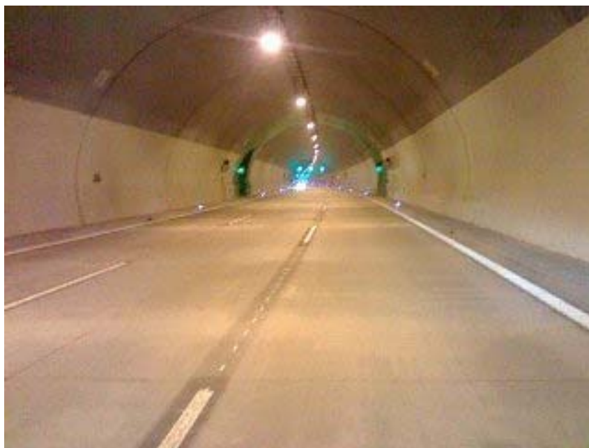
Obrázek 9 – Použití vodících trvale svítících knoflíků v tunelu
