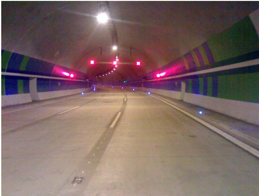
Obrázek 10 – Použití vodících trvale svítících knoflíků v tunelu
