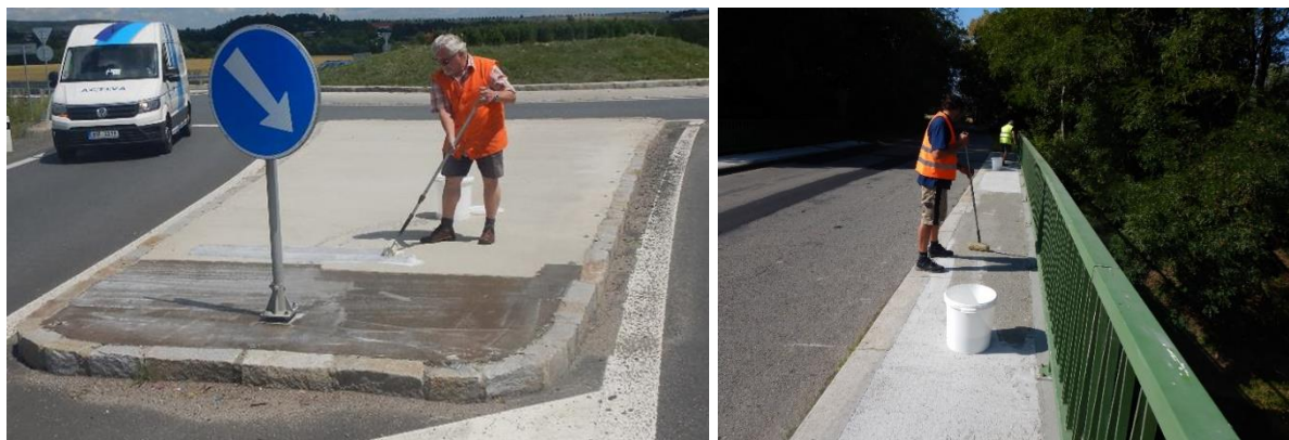
Obr. 5: Příklad ruční aplikace Emulze LO na silničních ostrůvcích a na mostních chodnících, zdroj: CDV
