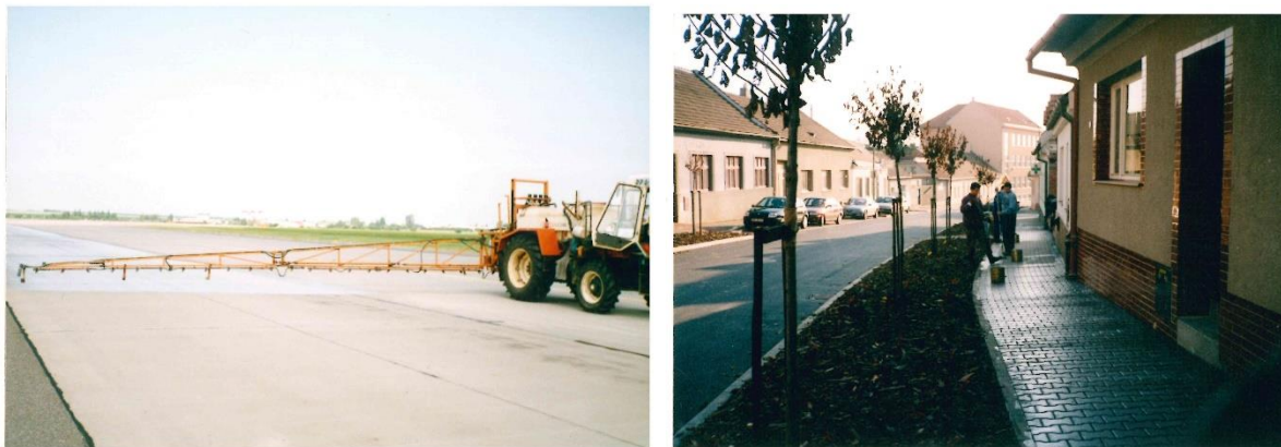
Obr. 4: Příklad aplikace lněné fermeže na letišti Náměšť nad Oslavou a v intravilánu obce na chodnících se zámkovou dlažbou, zdroj: CDV
