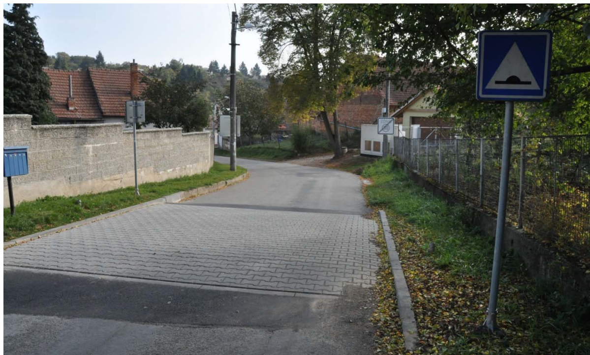
Obrázek 6 - Příklad dlouhého zpomalovacího prahu
