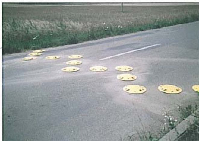
Obrázek 21 - Příklad umístění polštářů tvořených z prefabrikátů
