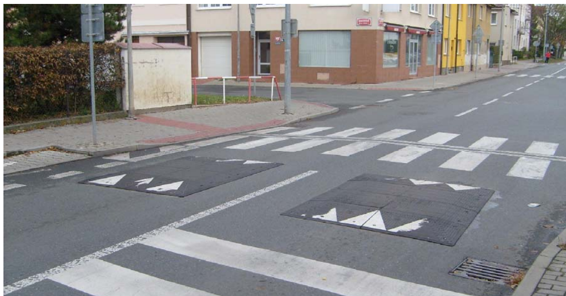
Obrázek 16 - Příklad umístění zpomalovacích polštářů před přechodem pro chodce
