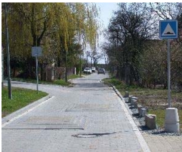
Obrázek 20 - Příklady umístění dvojice zpomalovacích polštářů na pozemní komunikaci
