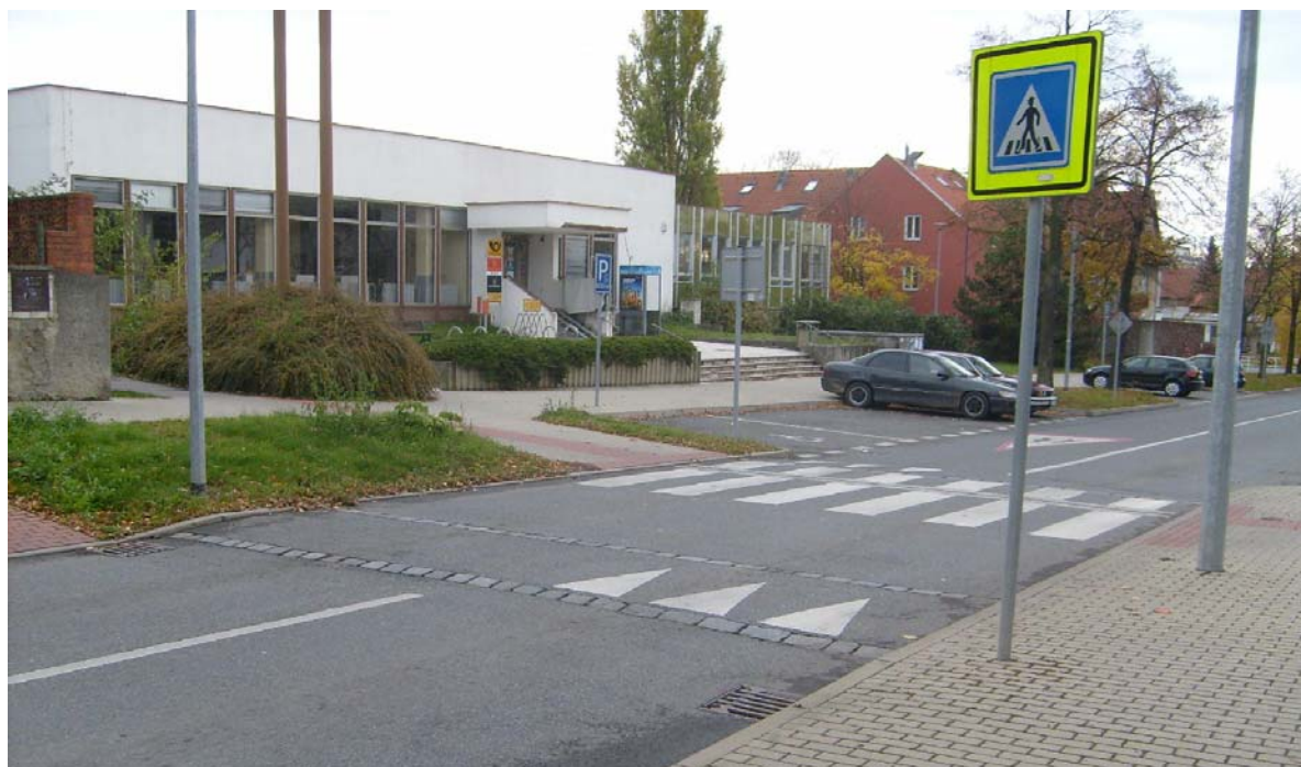
Obrázek 4 - Příklad dopravního značení zpomalovacího prahu s integrovaným přechodem pro chodce
