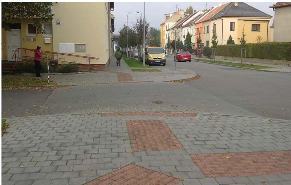
Obrázek 8 - Zpomalovací práh použitý jako místo pro přecházení
