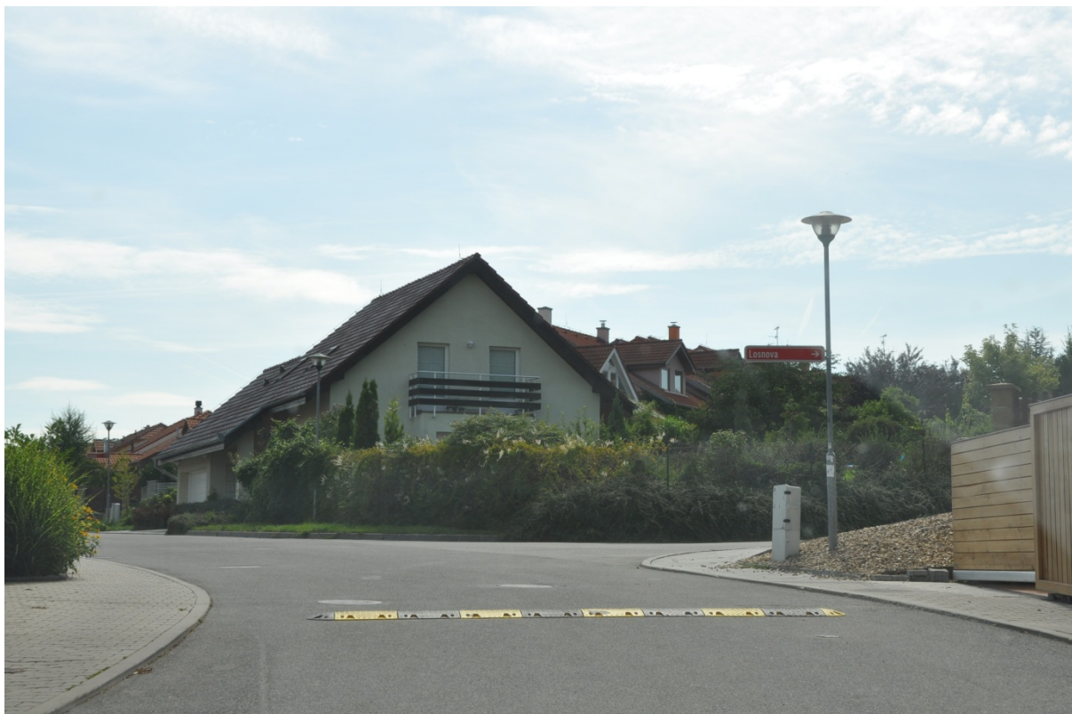
Obr. 8 Příklad umístění krátkého zpomalovacího prahu (Česká republika)
