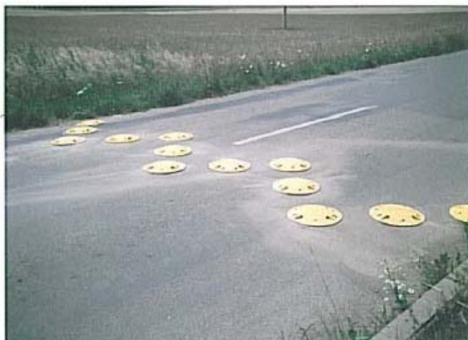
Obr. 50 Příklad umístění polštářů tvořených z prefabrikátů
