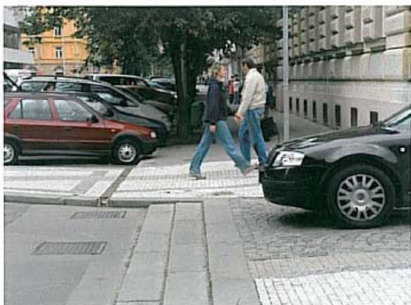
Obr. 34 Detail stupňovitého tvaru nájezdové rampy
