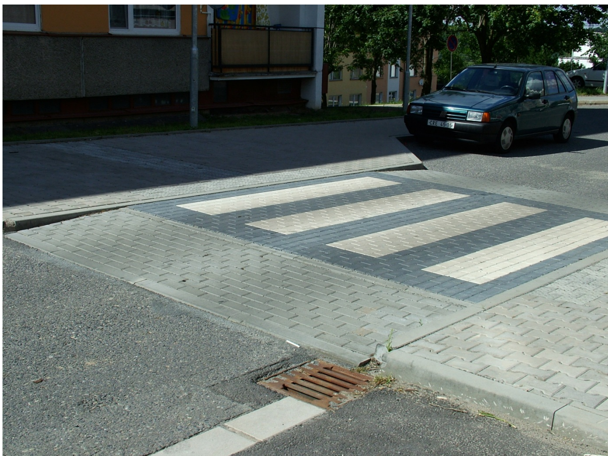
Obr. 11 Příklad dlouhého zpomalovacího prahu integrovaného s přechodem pro chodce
