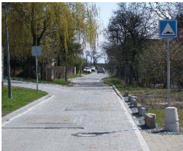
Obr. 47 Příklady umístění dvojic zpomalovacích polštářů na pozemní komunikaci
